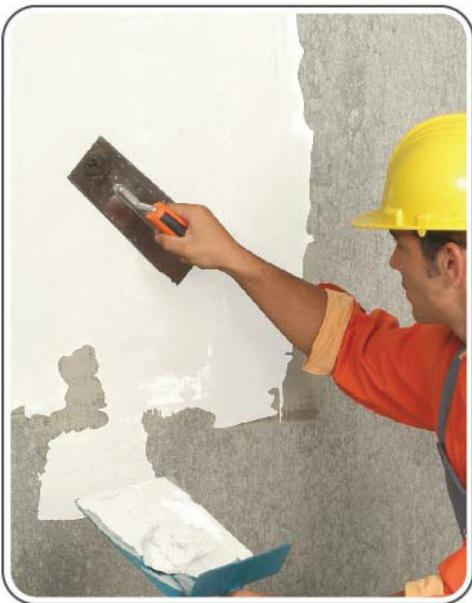
อะครีลิกสำเร็จรูป สำหรับงานฉาบบาง เพื่อปรับซ่อมผิวคอนกรีต รุพรู้นตามด ก่อนงานทาสี คุณลักษณะ TOA 102 D-Cote เป็นอะครีลิกชนิดพิเศษ สำเร็จรูป ใช้สำหรับงานฉาบบาง บนผนังอาคาร ฝ้า และเพดาน เพื่อซ่อมแซมแก้ไขรอยแตกร้าวขนาดเล็ก รอยแตกขยายงา รุพรู้นอากาศ รุพรู้นตามด ทำให้งานฉาบดูเรียบเนียน สามารถฉาบปิดผิวเม็ดทราย ทั้งพื้นผิวเก่าและใหม่ก่อนการทาสี
